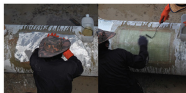
3. ปูชั้นทราย และวางเรียงแผ่นไฟเบอร์ กับชั้นทราย แล้วทาเรซินทับด้านบนตามภาครวมของผู้ผลิต
