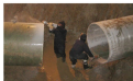
1. ตัดท่อบริเวณที่รั่ว ให้แยกเป็นสองด้าน
