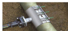
6. สต่อด้านที่เป็นจุดจ่ายน้ำด้วยหน้างาน แล้วทำการถมกลับ
