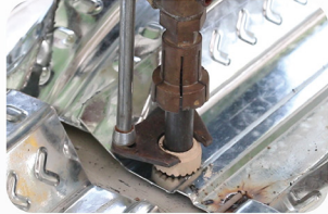
การเชื่อมด้วยเครื่องเชื่อม STUD โดยเฉพาะ
