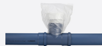
ภาพตัวอย่าง การครอบถุงพลาสติก ที่วาล์วเติมอากาศเดอรโก้ (DURGO AAVs) ระหว่างการก่อสร้าง
